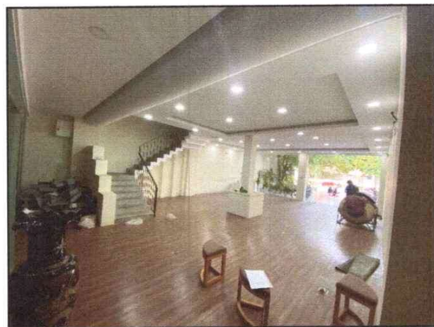
Hiện trạng tầng trệt
