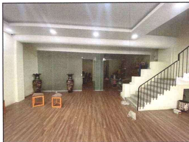
Hiện trạng tầng trệt
