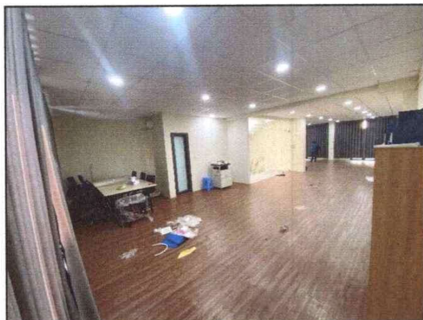
Hiện trạng tầng 2
