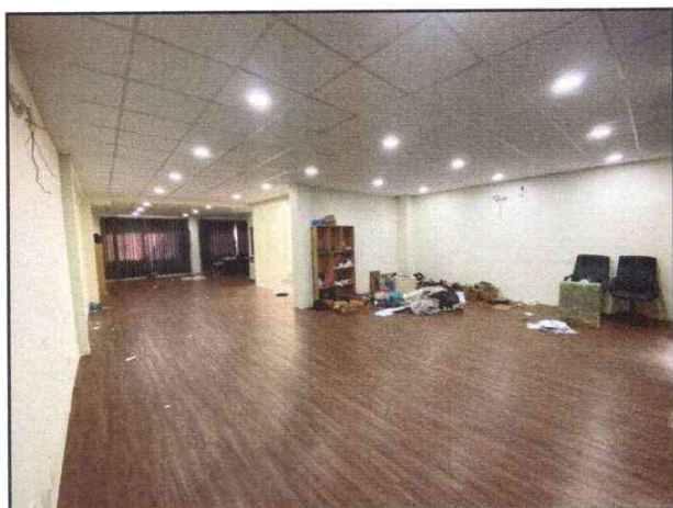
Hiện trạng tầng 2
