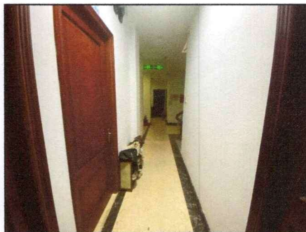
Hiện trạng tầng 5
