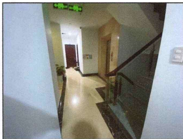
Hiện trạng tầng 2
