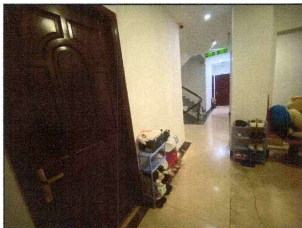
Hiện trạng tầng 4
