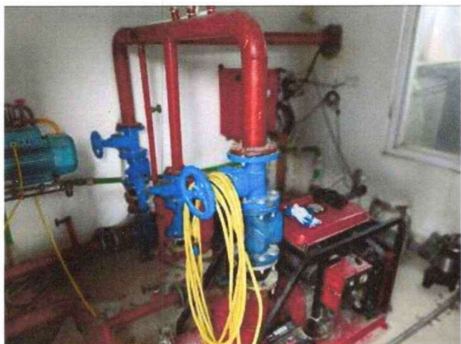
Thi công, lắp đặt hệ thống phòng cháy chữa cháy
