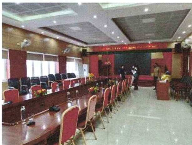
Thi công lắp đặt nội thất hội trường
