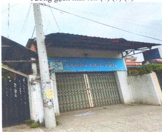
Tường gạch mái tôn (7)
