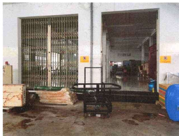
Hiện trạng nhà kho + nhà ăn
