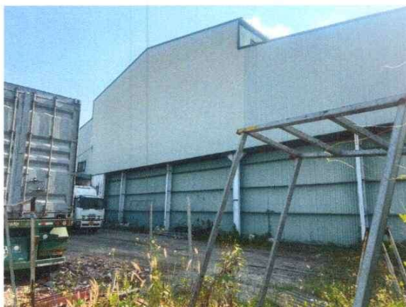
Hiện trạng nhà xưởng
