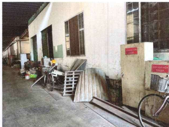
Hiện trạng nhà xưởng cơ khí
