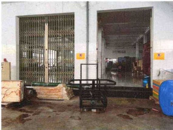
Hiện trạng nhà kho + nhà ăn
