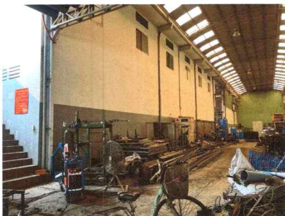
Hiện trạng nhà kho + nhà ăn
