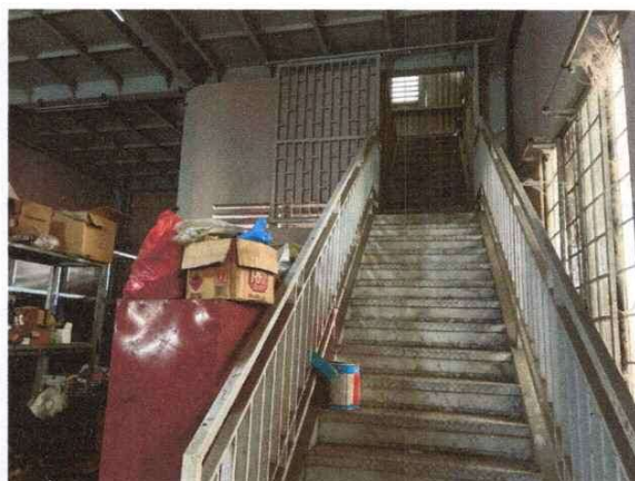
Hiện trạng nhà xưởng cơ khí
