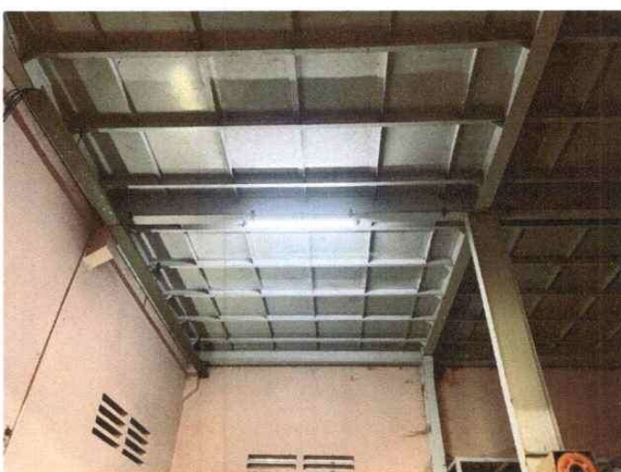
Hiện trạng nhà xưởng cơ khí
