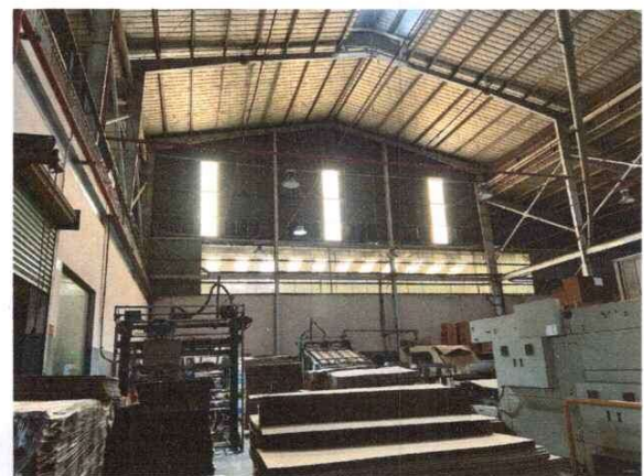
Hiện trạng nhà xưởng
