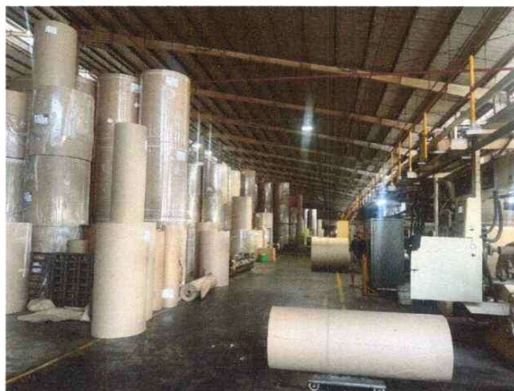
Hiện trạng nhà xưởng
