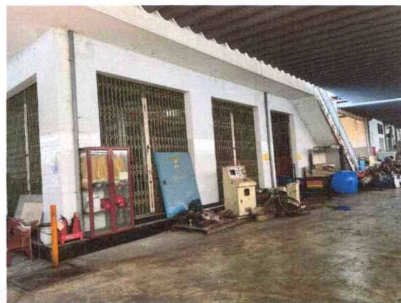
Hiện trạng nhà kho + nhà ăn
