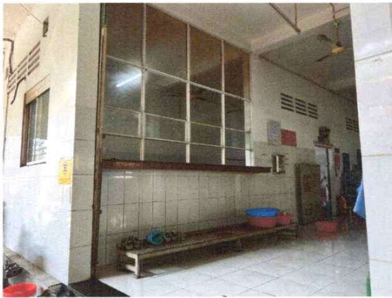
Hiện trạng nhà kho + nhà ăn
