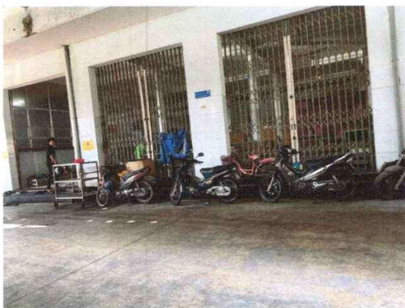
Hiện trạng nhà kho + nhà ăn
