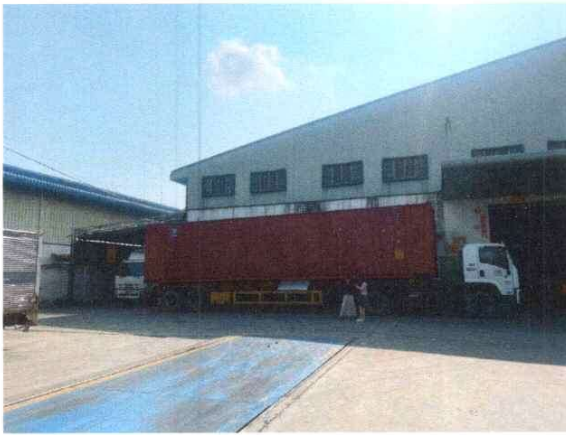
Hiện trạng nhà xưởng
