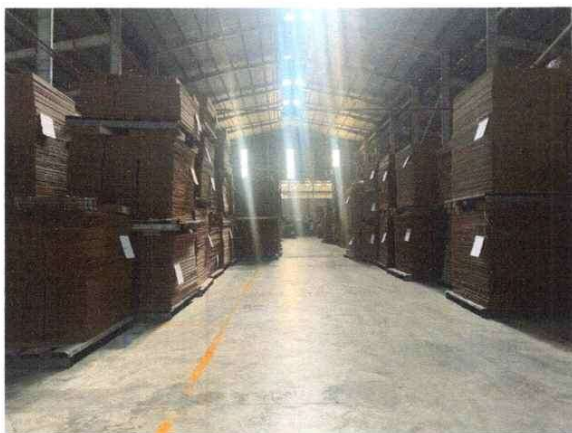
Hiện trạng nhà xưởng
