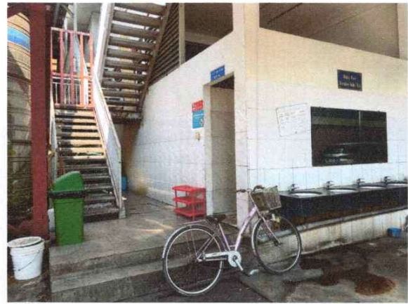
Hiện trạng nhà kho + nhà ăn
