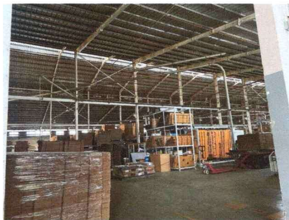
Hiện trạng nhà xưởng
