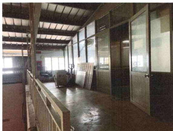
Hiện trạng tầng lửng nhà xưởng
