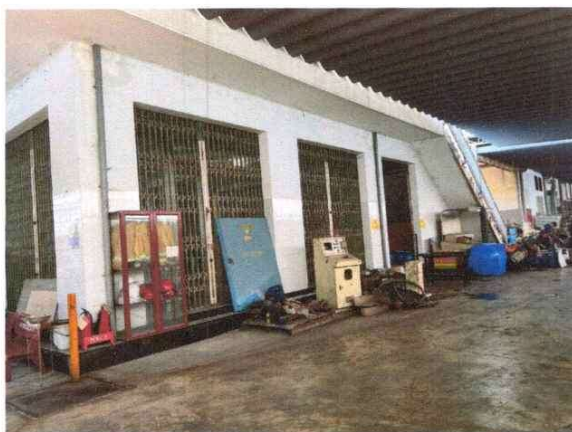
Hiện trạng nhà kho + nhà ăn
