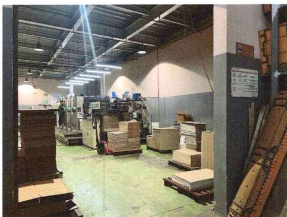
Hiện trạng nhà xưởng
