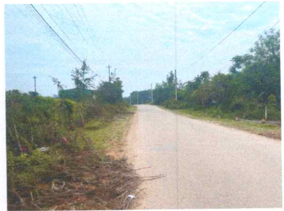
Đường Dạ Lê tiếp giáp tài sản
