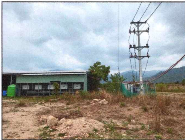
Hiện trạng hệ thống điện năng lượng mặt trời và hệ thống trạm biến áp (được lắp đặt trên thửa đất số 4)
