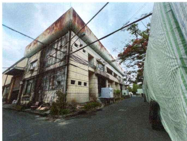
Hiện trạng tài xưởng sản xuất B1
