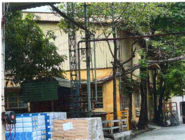
Hiện trạng nhà kho C
