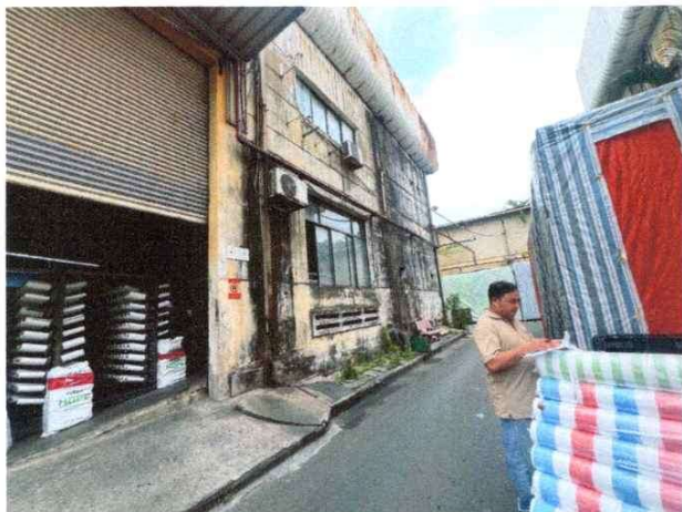
Hiện trạng tài xưởng sản xuất B2
