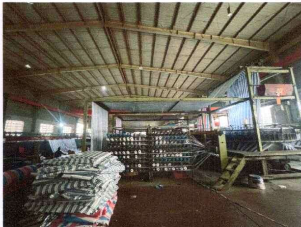
Hiện trạng tài xưởng sản xuất B2
