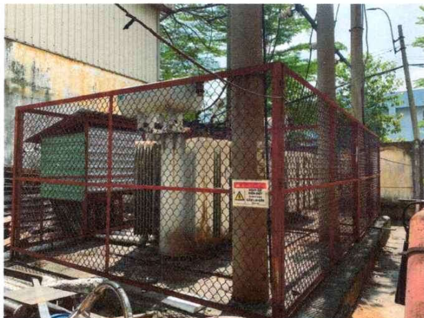
Hiện trạng trạm điện
