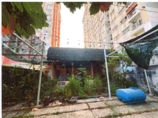
HIỆN TRẠNG TÀI SẢN - CỘT SẮT MÁI BẠT KÉO (24)
