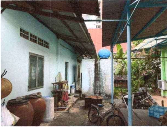
HIỆN TRẠNG TÀI SẢN – TƯỜNG GẠCH MÁI TÔN (14)
