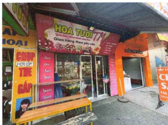
HIỆN TRẠNG TÀI SẢN – TƯỜNG GẠCH MÁI TÔN (9)
