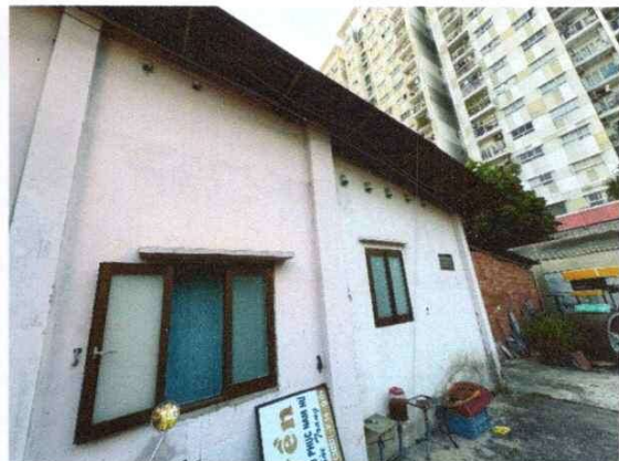
HIỆN TRẠNG TÀI SẢN – TƯỜNG GẠCH MÁI TÔN (19)
