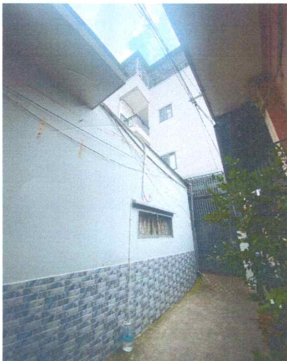
Nhà 3 tầng (thời điểm tháng 10/2024)
