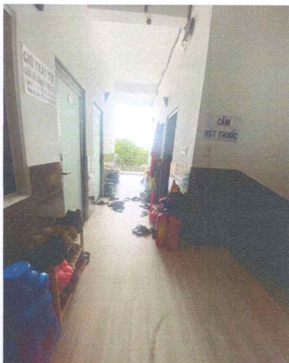
Nhà 3 tầng (thời điểm tháng 10/2024)
