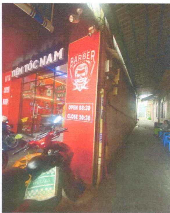
Nhà cấp 4 (thời điểm tháng 10/2024)
