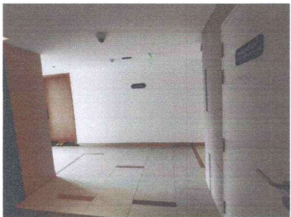
Hành lang tòa nhà
