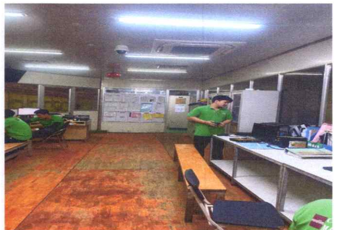
Hệ thống lập trình PLC
