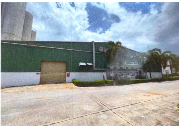
Nhà xưởng (giai đoạn 1)
