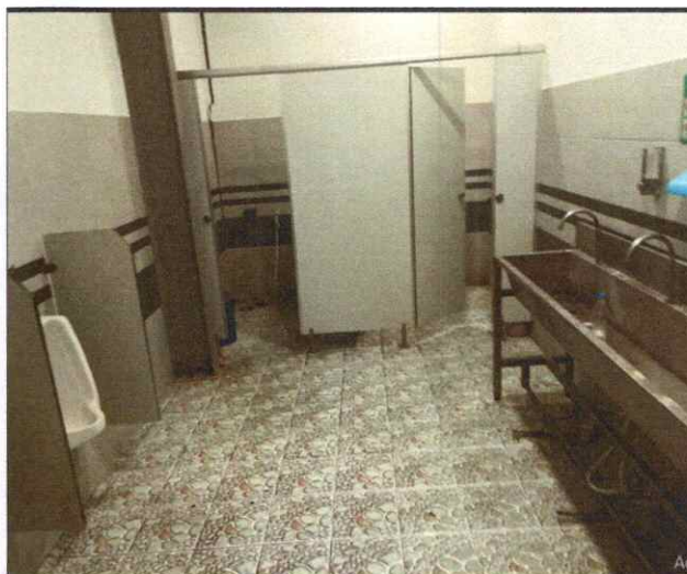
Hệ thống PCCC và nước sinh hoạt
