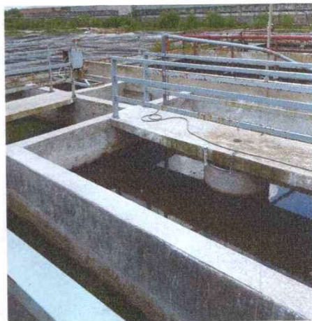
Nhà xử lý nước thải
