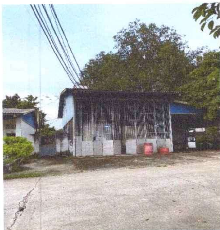
Nhà che máy phát điện
