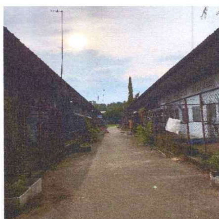
Nhà ở công nhân
