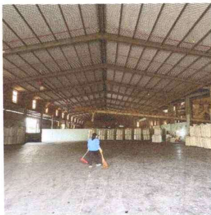
Xưởng chế biến cám
