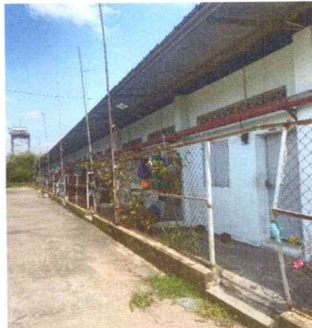
Nhà ở công nhân 2
