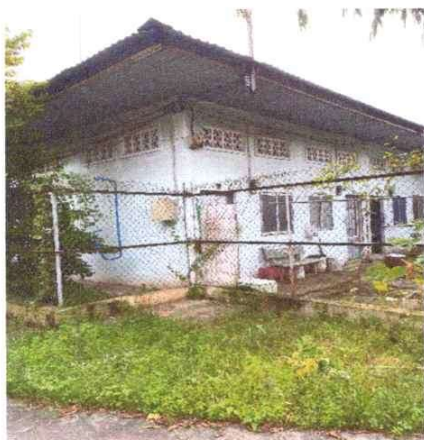
Nhà ở công nhân
