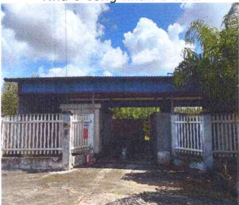
Nhà che máy phát điện
