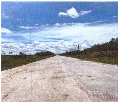
Đường Công Vụ
