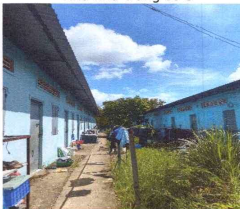
Nhà ở công nhân 1 và 2
