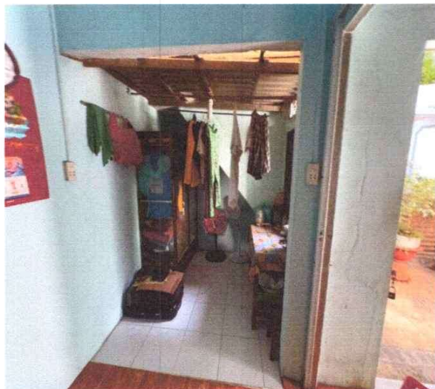
HIỆN TRẠNG TÀI SẢN (NHÀ SỐ 405)
