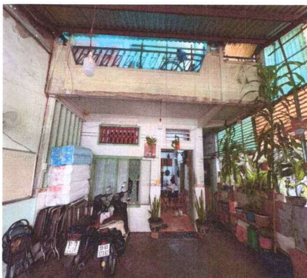
HIỆN TRẠNG TÀI SẢN (NHÀ SỐ 405)
