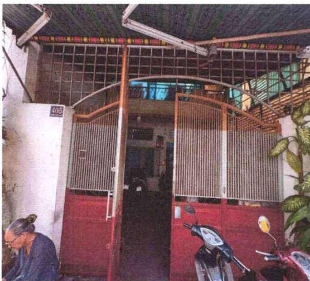
HIỆN TRẠNG TÀI SẢN (NHÀ SỐ 405)
