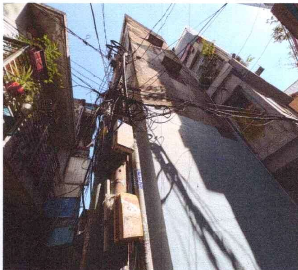
HIỆN TRẠNG TÀI SẢN (NHÀ SỐ 407/2)
