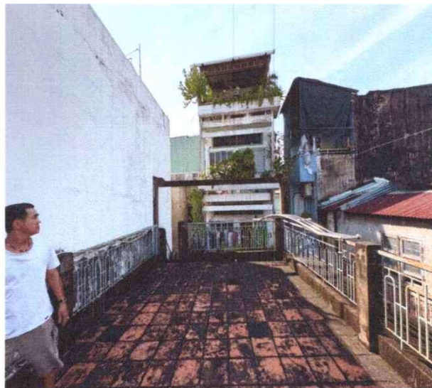
HIỆN TRẠNG TÀI SẢN (NHÀ SỐ 405)
