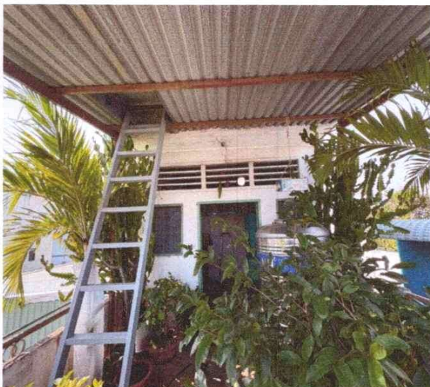
HIỆN TRẠNG TÀI SẢN (NHÀ SỐ 407/2)
