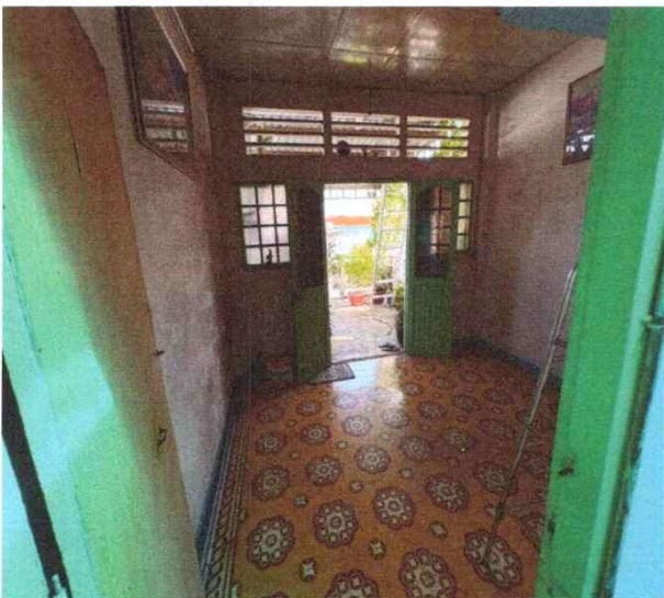
HIỆN TRẠNG TÀI SẢN (NHÀ SỐ 407/2)
