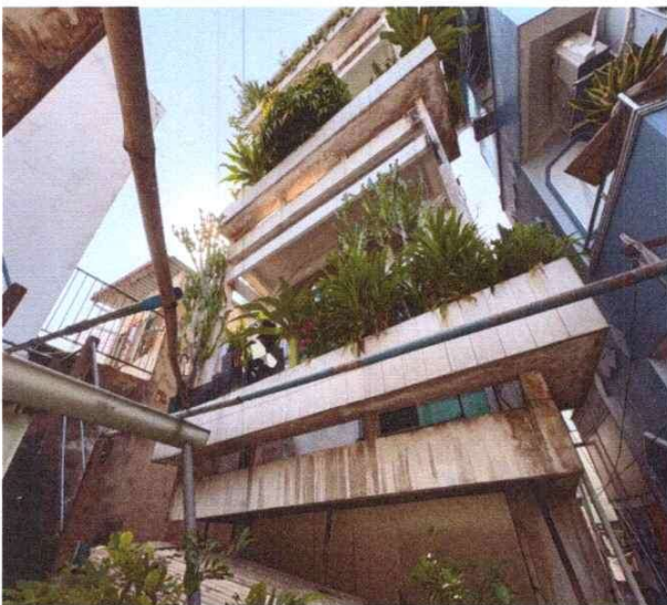
HIỆN TRẠNG TÀI SẢN (NHÀ SỐ 407/2)
