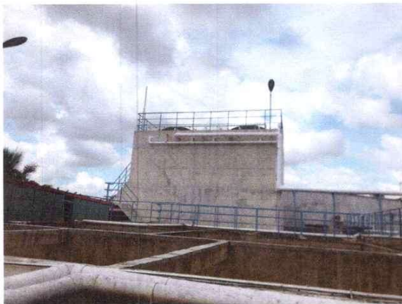
Bể kị khí UASB
