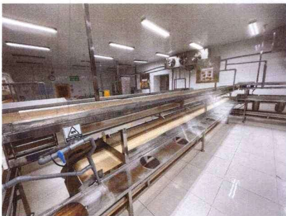
Hệ thống băng tải cho máy gọt vỏ Xoài, do bên bán cung cấp và lắp đặt
