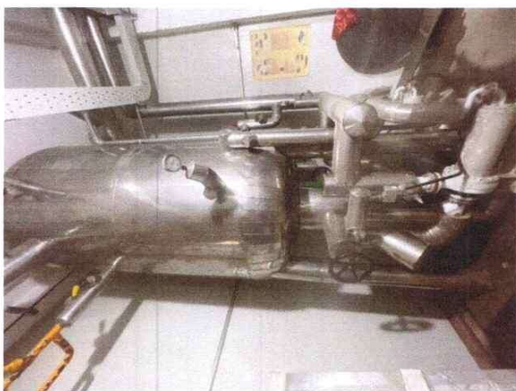
Hệ thống lạnh NH3 và hạng mục xây dựng (Beton nền móng máy, xây dựng,...)
