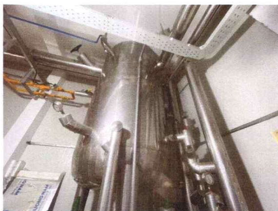
Hệ thống lạnh NH3 và hạng mục xây dựng (Beton nền móng máy, xây dựng,...)
