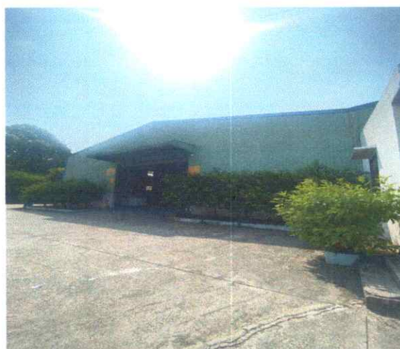
Hiện trạng nhà xưởng
