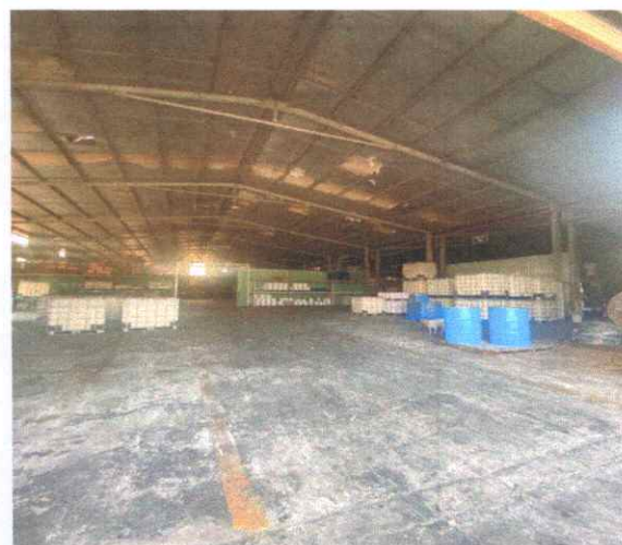
Hiện trạng nhà xưởng
