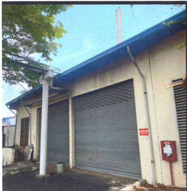
Nhà nồi hơi
