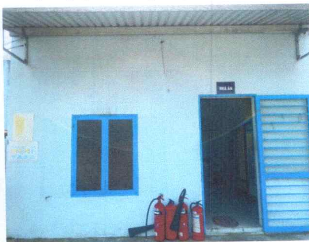
Hiện trạng nhà ăn
