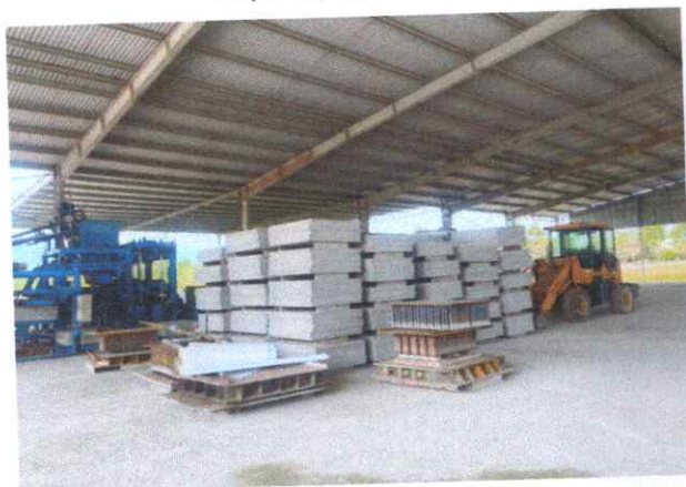
Hiện trạng nhà xưởng đặt dây chuyền máy
