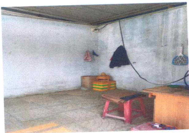
Hiện trạng nhà bảo vệ
