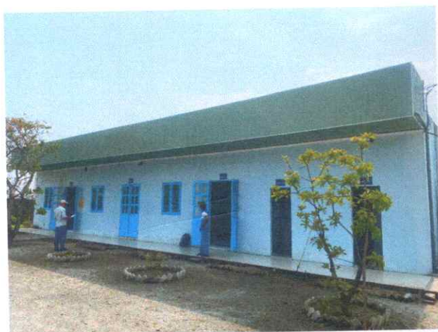
Hiện trạng nhà văn phòng + nhà vệ sinh
