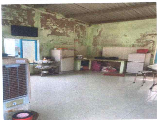
Hiện trạng nhà ăn
