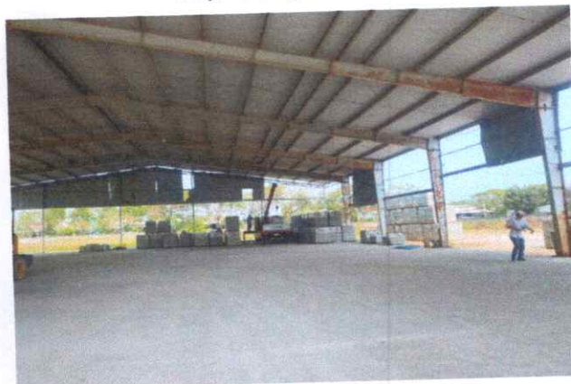
Hiện trạng nhà xưởng đặt dây chuyền máy
