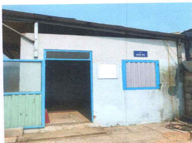
Hiện trạng nhà bảo vệ
