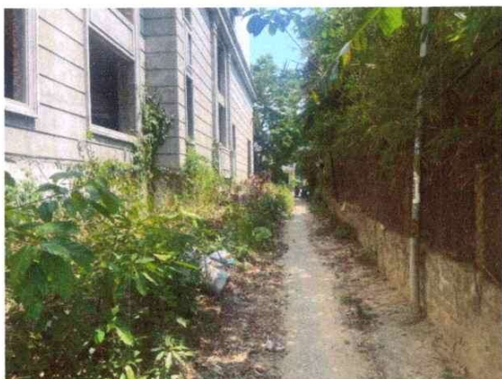
HÈM BÊ TÔNG
