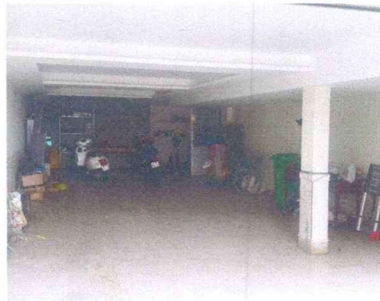
Hiện trạng tầng hầm biệt thự
