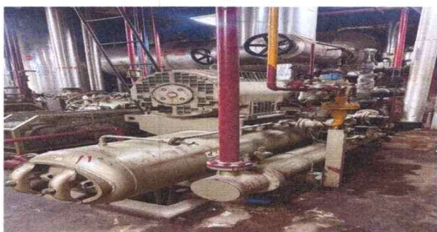
Máy nén MC N2016LSC-51, Motor 180KW
