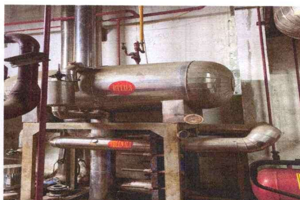
Thiết bị làm lạnh nước điều hòa không khí
