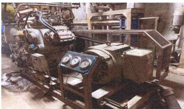
Máy nén MC N6WBH, Motor 110KW
