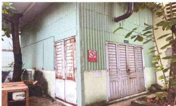
Nhà để máy phát điện
