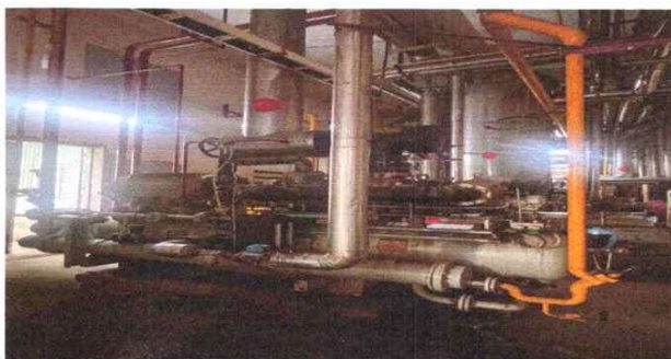
Máy nén MC N2016MSC-51, Motor 200KW
