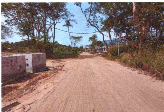
Đường tiếp giáp thửa đất số 1224, 1225, 12234, 1235, 1236
