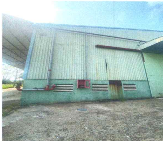
Hiện trạng nhà xưởng
