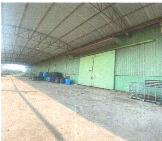
Hiện trạng nhà xưởng
