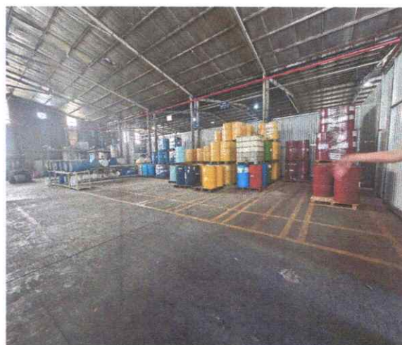
Hiện trạng nhà xưởng
